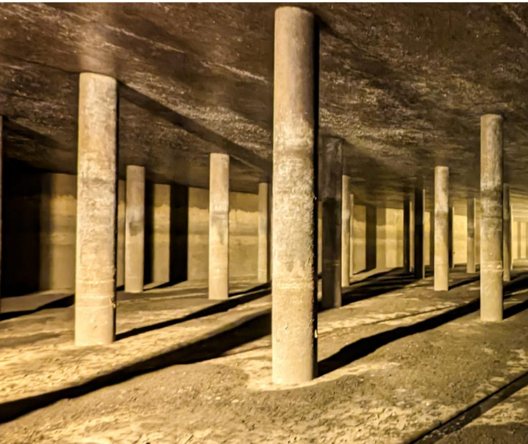
Das Regenüberlaufbecken Schenkendorfstraße hat ein Rückhaltevolumen von 20.000 Kubikmetern. Nach dem Ende der Regenfälle entleert sich das Becken im freien Gefälle in das Kanalnetz und das Mischwasser fließt weiter ins Klärwerk.
