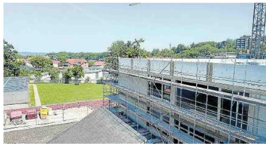
Der Rohbau der WvS-Erweiterung steht, innen werden bereits Durchbrüche zum Bestandsgebäude geschaffen. Foto: Schlegel
