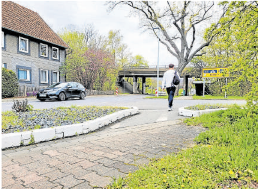
Als besondere Gefahrenstelle haben die Schulweghelfer die Auf- und Abfahrt neben der B4-Brücke in Westeroode ausgemacht. Archivfoto: Exner
